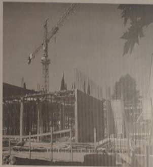
Prospettiva a ritroso: rimasti i lavori di ristrutturazione e ampliamento nella scuola media "Sant'Abbondio". In attesa che questi si trasformi nel polo scolastico di Montelupo Fiorentino gli alunni sono stati trasferiti all'ex Colorificio, vicino al centro commerciale Coop.
