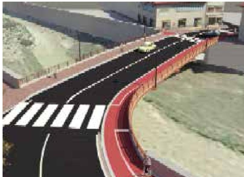
Riorganizzazione della carreggiata sul ponte con un leggero allargamento dell'impalcato, sia a monte sia a valle, separando i percorsi pedonali da quelli ciclabili
