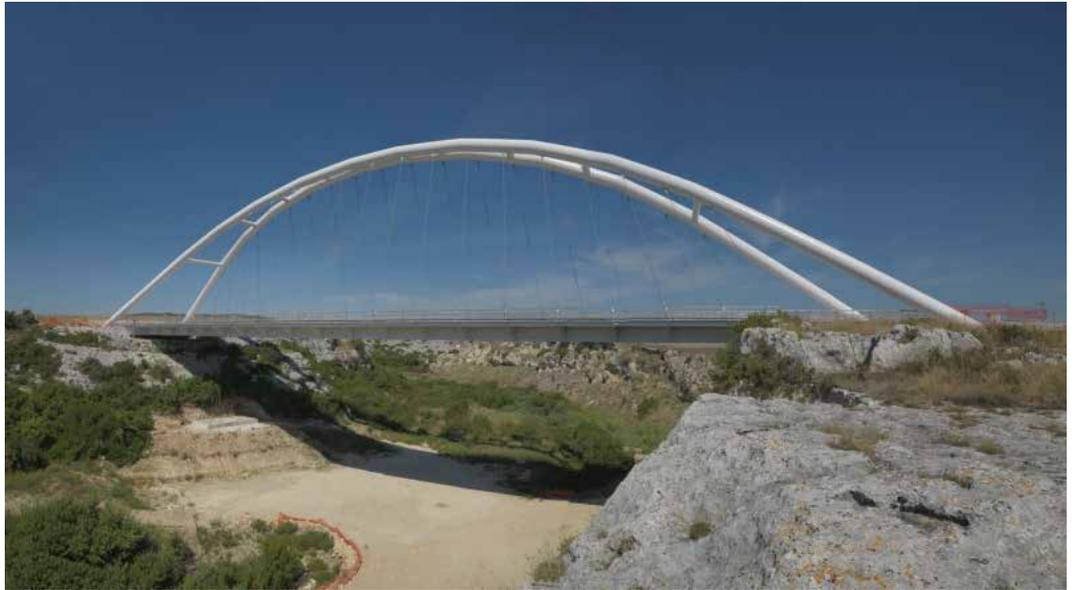
Particolari gli accorgimenti pensati per garantire la sicurezza della struttura e il contrasto all'usura: il ponte è progettato per resistere a sollecitazioni sismiche anche di elevata entità grazie alla sua possibilità di spostamento di 25 cm sui pilastri; i tubi saranno a tenuta stagna con una vernice antiruggine pensata per durare almeno 20 anni.
